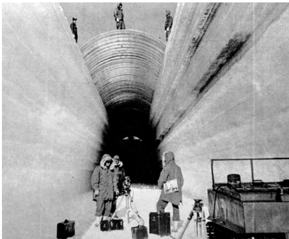
写真③米軍がグリーンランドに建設を進めた「アイスマン」核ミサイル基地。冰雪を素掘りし、半円形の鉄製の屋根をかけていく作業を続けた＝米陸軍資料「Camp Century evolution of concept and history of design construction and performance」から
